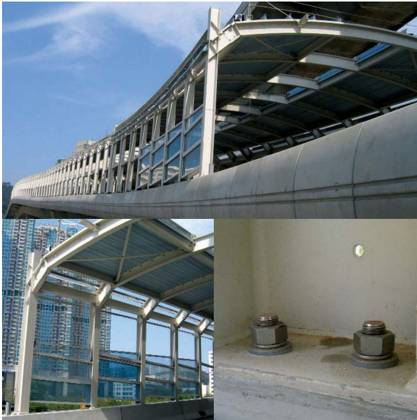
Route 8 - Lai Chi Kok Viaduct (HY/2003/01) 八號幹線 - 荔枝角高架路
